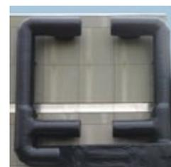
Un chevauchement de 20 mm seulement est suffisant pour relier les pièces de matériau et assurer un revêtement absolument étanche des tuyauteries. WrapTec peut être étiré dans tous les sens jusqu'à 50 %.
